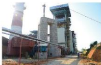
▲ Hình 9.7. Nhà máy điện sinh khối mía đường Tuyên Quang
